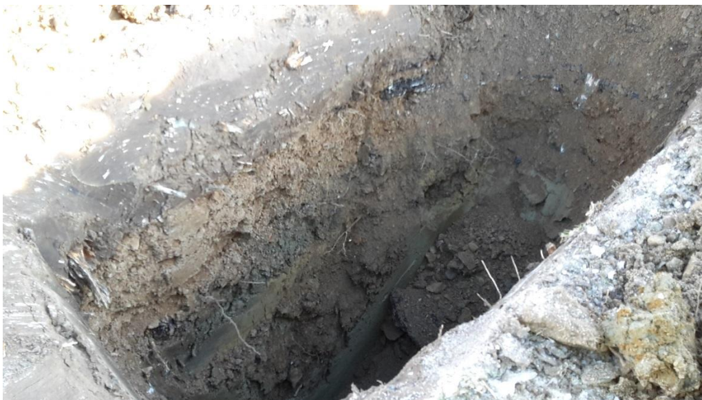
Figur 5. Provgrop 1801, vid parkeringen. Den ytliga mulljorden underlagras av en asfaltsyta, sedan följer fyllnadsmaterial ner till 0,7 meters djup. Under fyllnadsmaterialet påträffas silt och lera.
